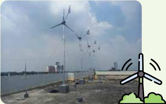
Proyek Pemasangan Pembangkit Listrik Tenaga Banyu (PLTB) yang berlokasi di Pusgiwa Universitas Indonesia, Depok ini mempunyai kapasitas 4 kWp. Energi yang didapatkan dari PLTB ini digunakan untuk menerangi lampu-lampu taman di Gedung Pusgiwa UI yang berjumlah 25 unit lampu taman dan 2 unit lampu sorot LED. Kami berkontribusi untuk mengurangi emisi gas karbon sebesar 2,7 Ton CO<sub>2</sub>/tahun.
